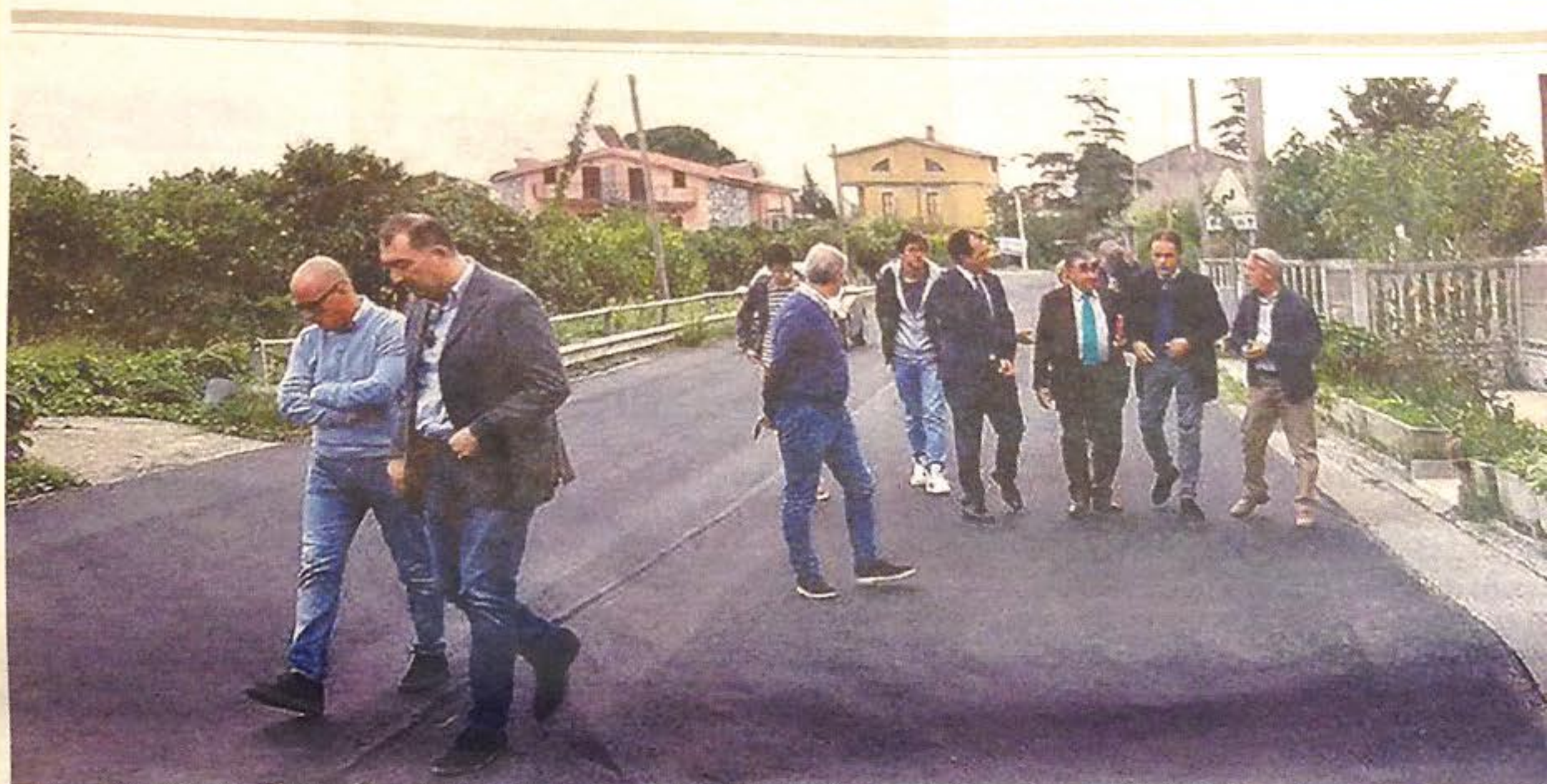
Il sopralluogo. Tecnici e amministratori a Davoli, anche qui il presidente della Provincia Enzo Bruno non si è sottratto ad annunciare il suo impegno nell'immediato futuro
